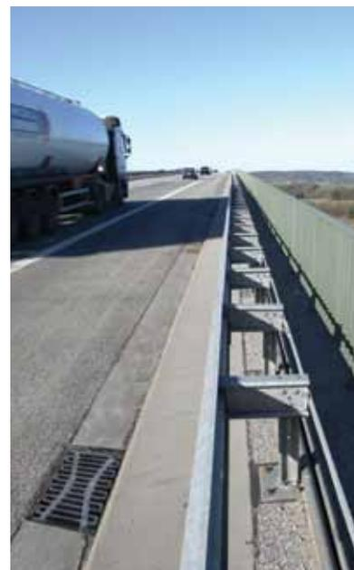
Крепление - фиксатор из нержавеющей стали.
