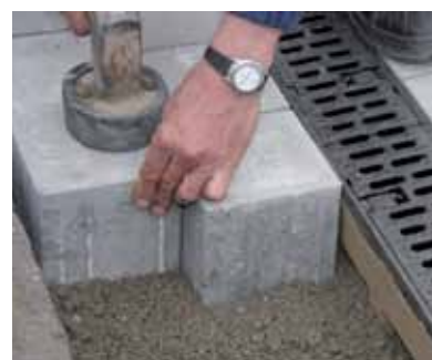
6. Выполняется мощение вдоль линии канала. При этом необходимо учитывать температурное расширение дорожного покрытия.
