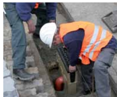
3. Выполняется подключение к коллектору через стандартный пескоуловитель.
