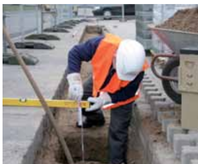
1. При помощи уровня определяется отметка поверхности и отметка верха основания канала.
