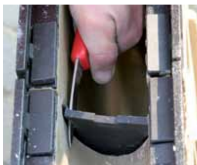
5. После монтажа системы в торцевой стенке пескоуловителя вырезается отверстие нужного сечения.
