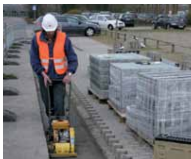
2. Формирование основания канала. Укладывается бетон соответствующего класса и трюмбуется машиной.
