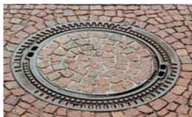
Ливнеприемный люк из чугуна выполняет 2 функции - ограждает колодец и осуществляет точечный водоотвод.
